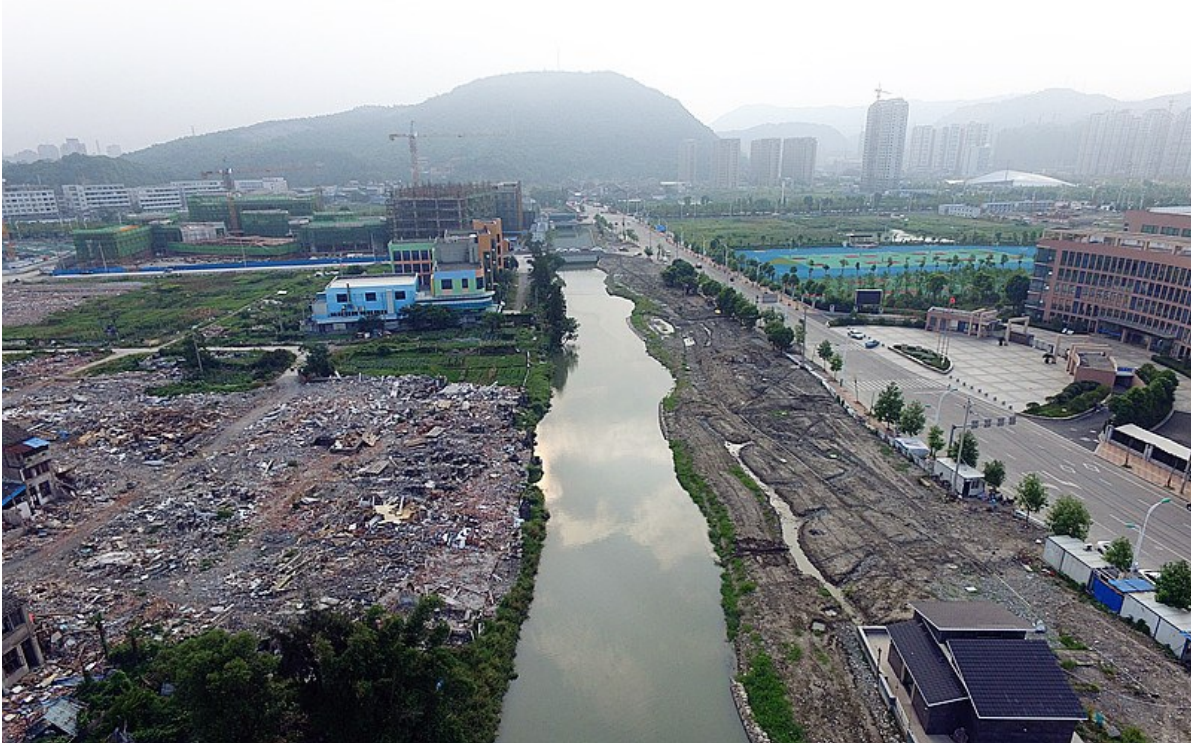
现在的仙桥河西垟段水岸同治项目正在施工
