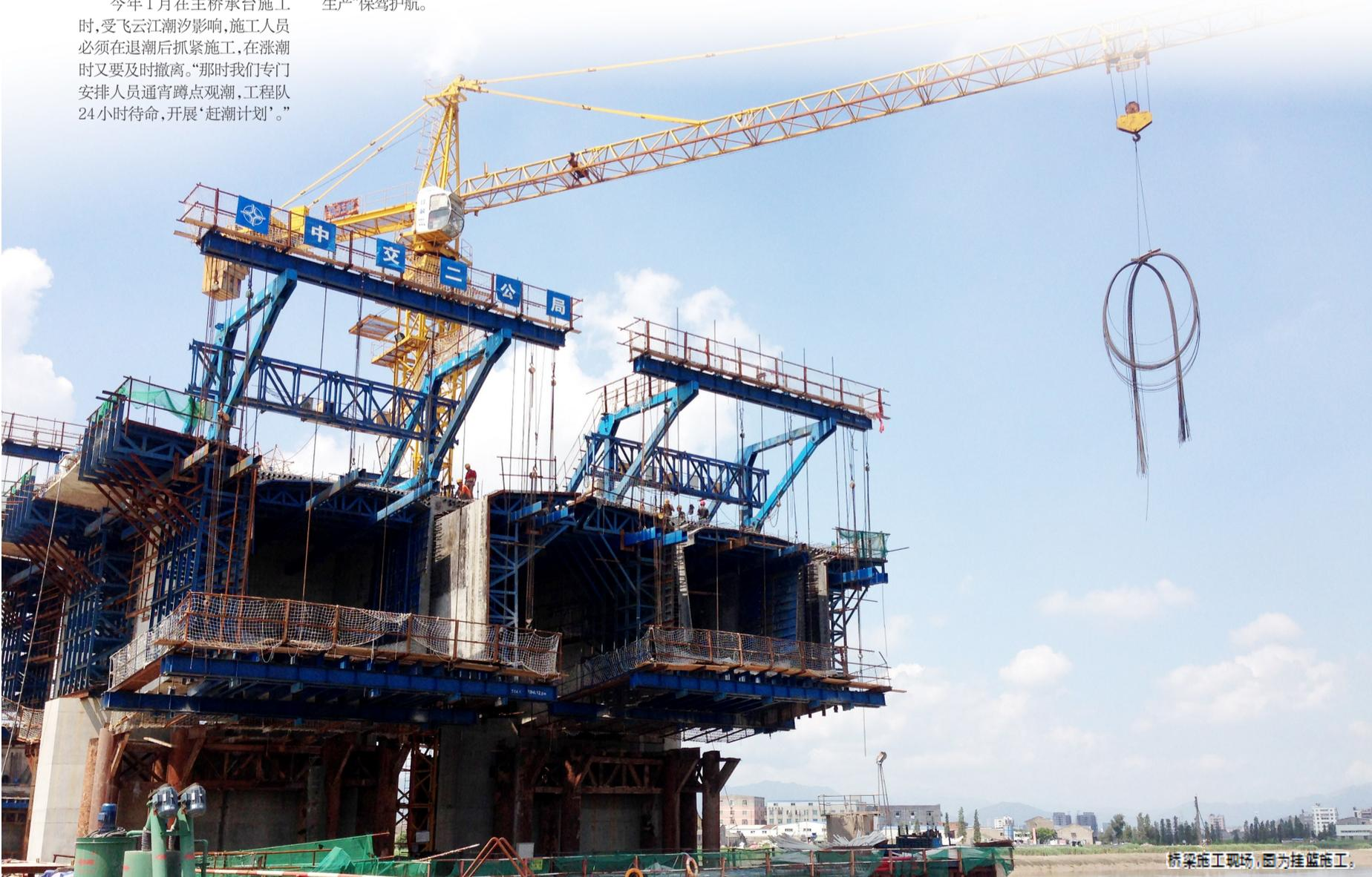
桥梁施工现场,因为挂篮施工。
