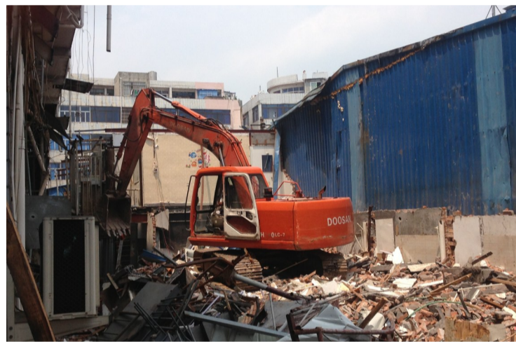
塘下办事处拆出消防安全通道
