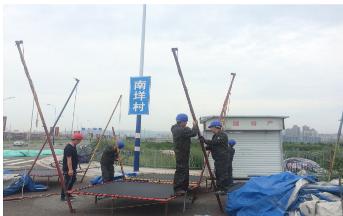
执法人员正在拆除游乐设施
