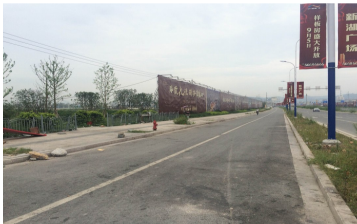
整治后的新湖广场周边道路恢复整洁面貌
