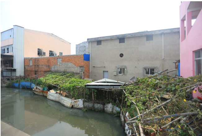
黄家浹违章建筑拆除前
