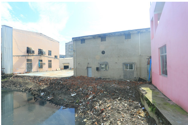
黄家浹违章建筑拆除后
