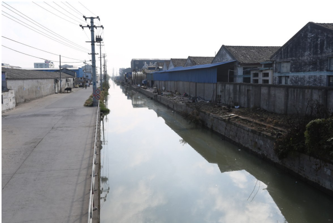
华表沥违章建筑拆除后
