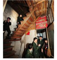
**7** 针对拒不整改的出租房，塘下镇组建一支包括各办事处、电力、水力、住建、市场监管等多部门工作人员在内的综合执法队伍，通过采取停电水、锯断木楼梯、拆除木隔断等强制措施，督促出租房整改。图为执法人员将韩田村一存在消防隐患的木楼梯锯断。
