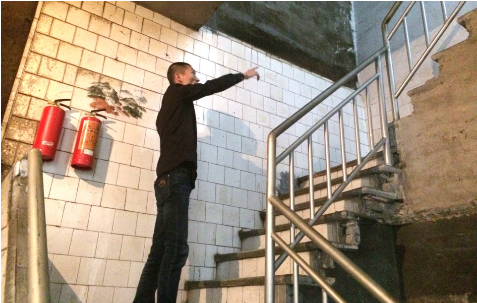
出租房原主的木质楼梯已被改为水泥楼梯
