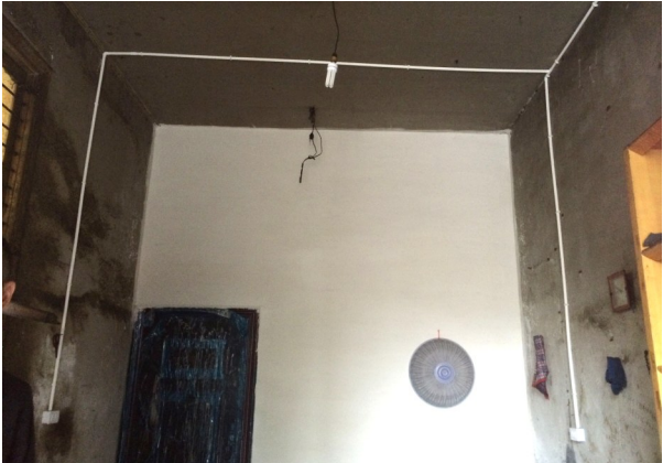
电线套管后整齐贴墙
