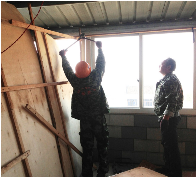
执法人员拆除合用房的易燃隔断
