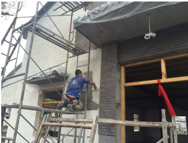
施工人员正在刷白墙
