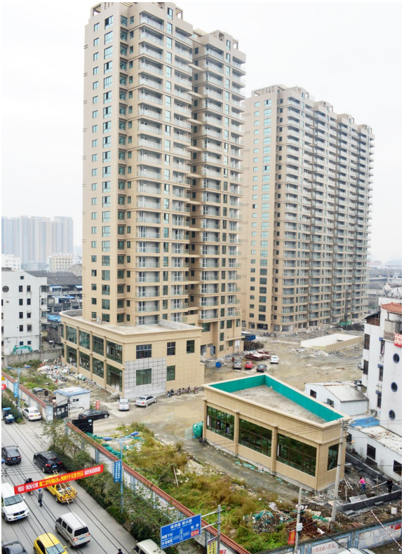
安置留地建设项目 富中锦园 一角
