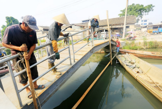
黄家泱河堰坝现场
