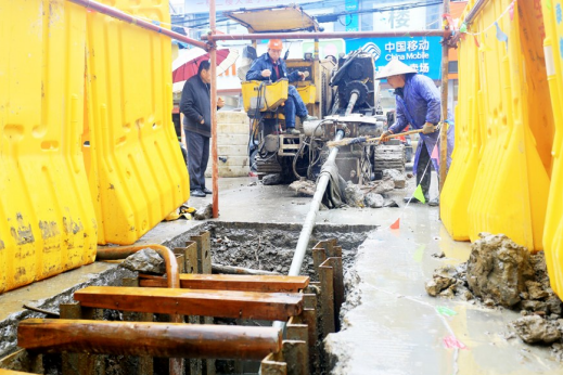
第四期截污纳管牵引施工现场
