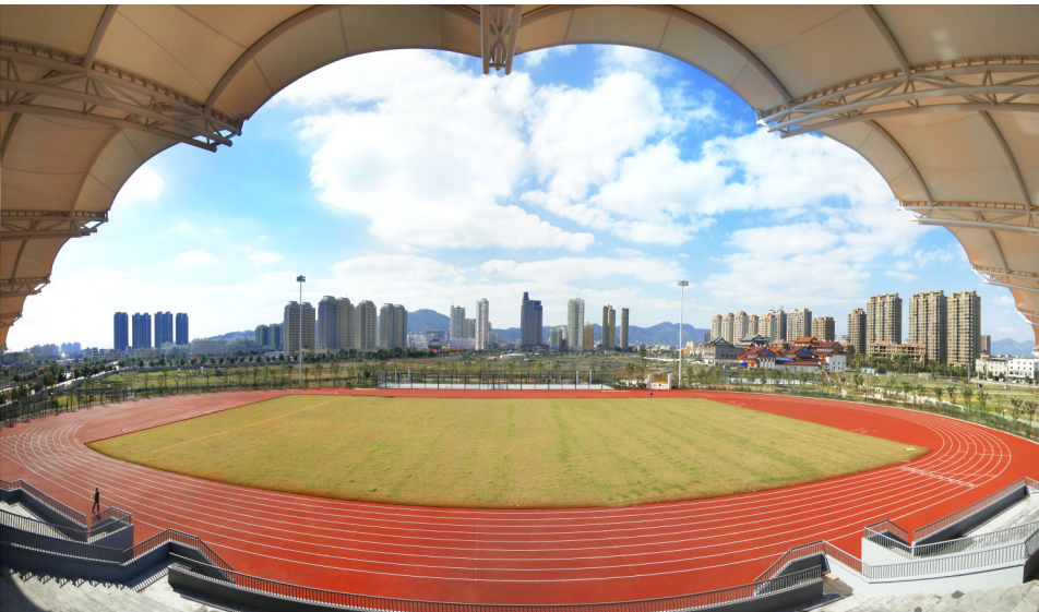
日前,塘下全民健身中心的400米标准跑道完成塑胶铺设和划线工作,红色的塑胶跑道全貌已呈现。该健身中心设有4个网球场、670个座位,现工程已进入收尾阶段。工程验收通过后,该健身中心将会对外开放。(特约记者 曹建光 记者 杨微微)
