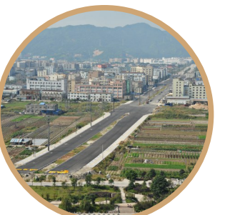
国泰路面基本完工(杨微微)
