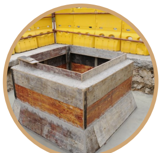
截污纳管施工现场(杨微微)
