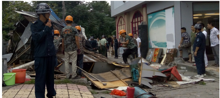
对隆山东路的违章电话亭进行拆除
