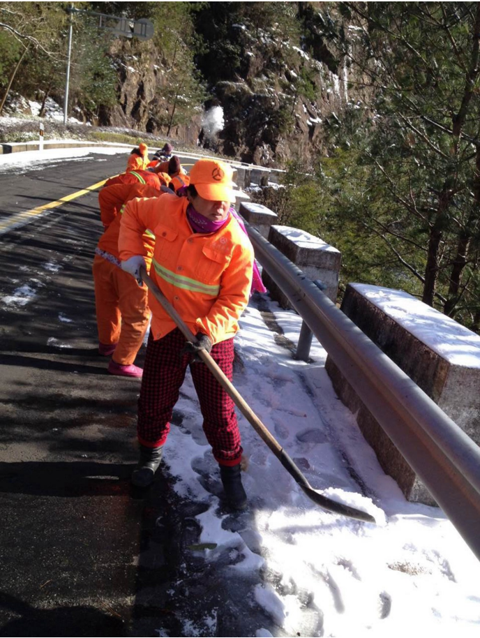
公路局抢修人员在为青岱线除积雪
