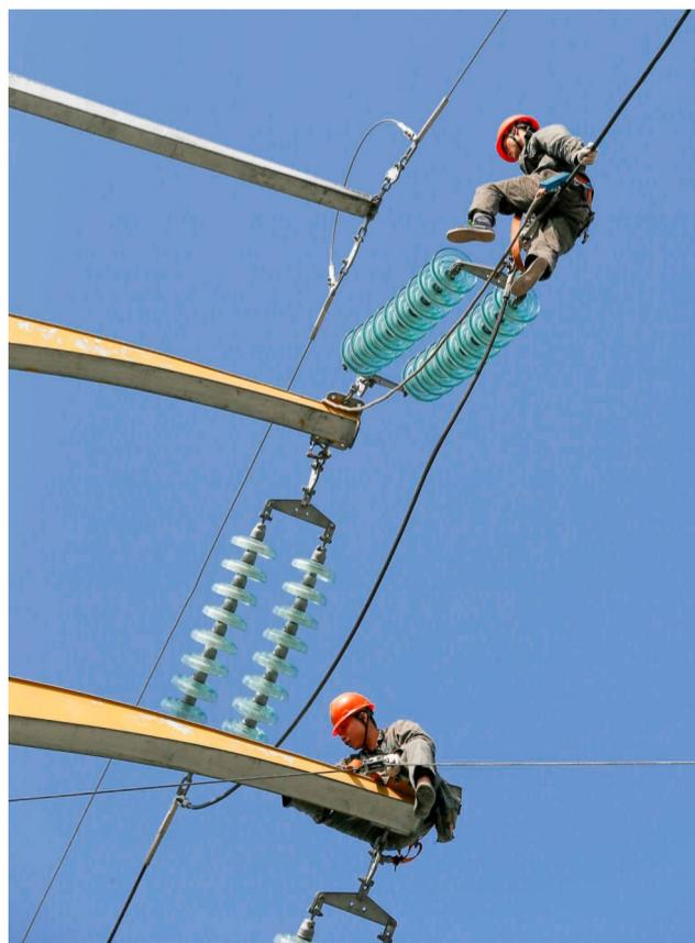
日前,电力工人正拆除瑞祥新区院士路110千伏架空线路的六基架空杆。为适应城市建设发展,自2015年,市供电公司积极配合市政府为民办实事电缆入地工程改造,大力推进城市新区设施改造,将纵横交错的架空线改为地下电缆。截止目前,已经完成瑞祥新区院士路110千伏铁塔架空线路的切断和架空杆线路的拆除,并将原先架空线路埋入地下,改造完成后的院士路视野将更加宽阔。
