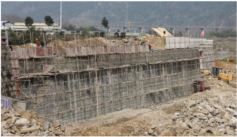
石龙溪防洪堤施工现场 (通讯员 戴瑞林)
