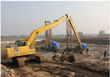
飞云江治理一期 2 标段施工现场 (通讯员 戴瑞林)
