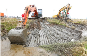
曹村港治理开工现场 (记者 庄颖超)
