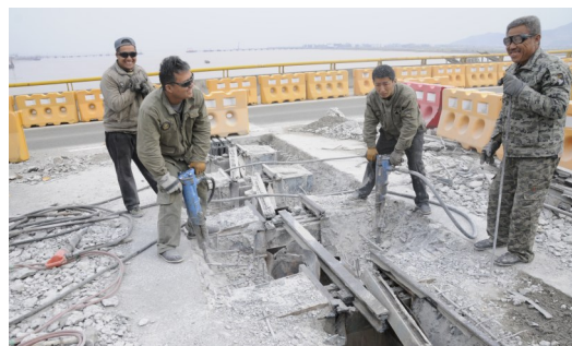
瑞安大桥上施工人员在修复伸缩缝
