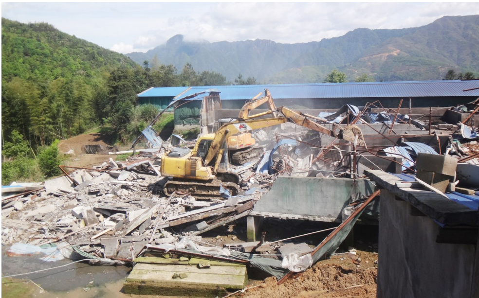
挖掘机的拆除违章养殖场
