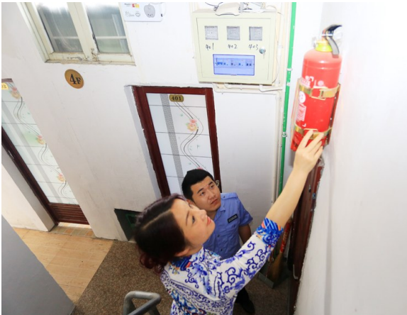
出租房整改后面貌一新(通讯员 林明锋)
