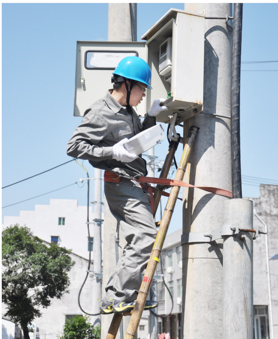
电力工作人员在岸上安装电表,方便岛上用电。
