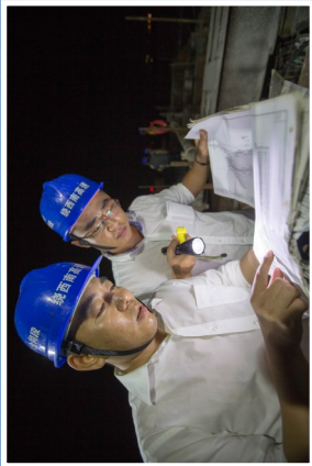
现场技术人员按照图纸对合龙段的钢筋、预应力管道安装等进行验收
