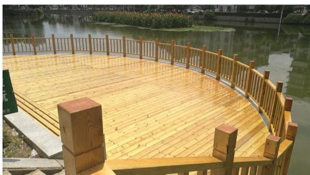
了解到,该平台约为90平方米,有26条栏杆,现均采用防腐木材料新建,同时采用了户外防腐漆保护。“户外护栏风吹雨打,采用防腐木材料更安全,
