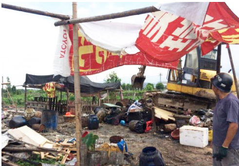
拆除“返潮”非法养猪场
