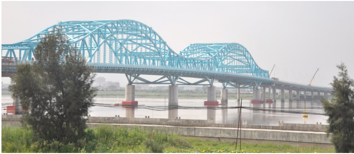
飞云江五桥尚在施工中
