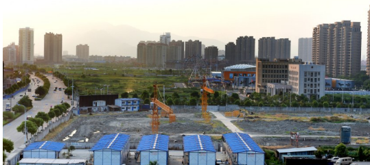
凤凰花园施工现场
