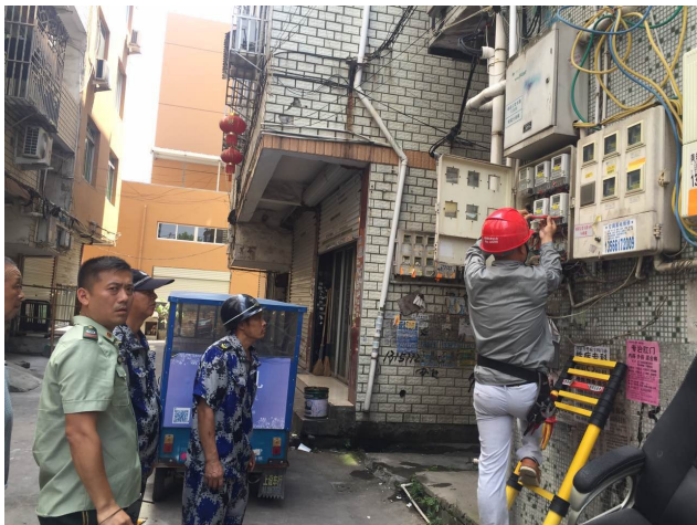
消防隐患整治现场
