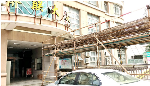
物业在大厦入口搭建的临时安全通道
