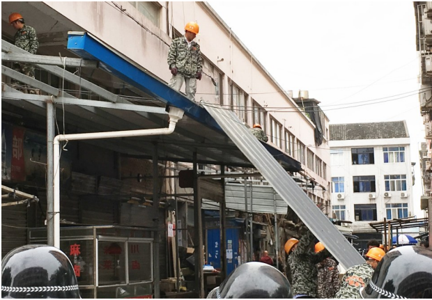
11月8日 ,桥邻村菜市场拆违现场。
