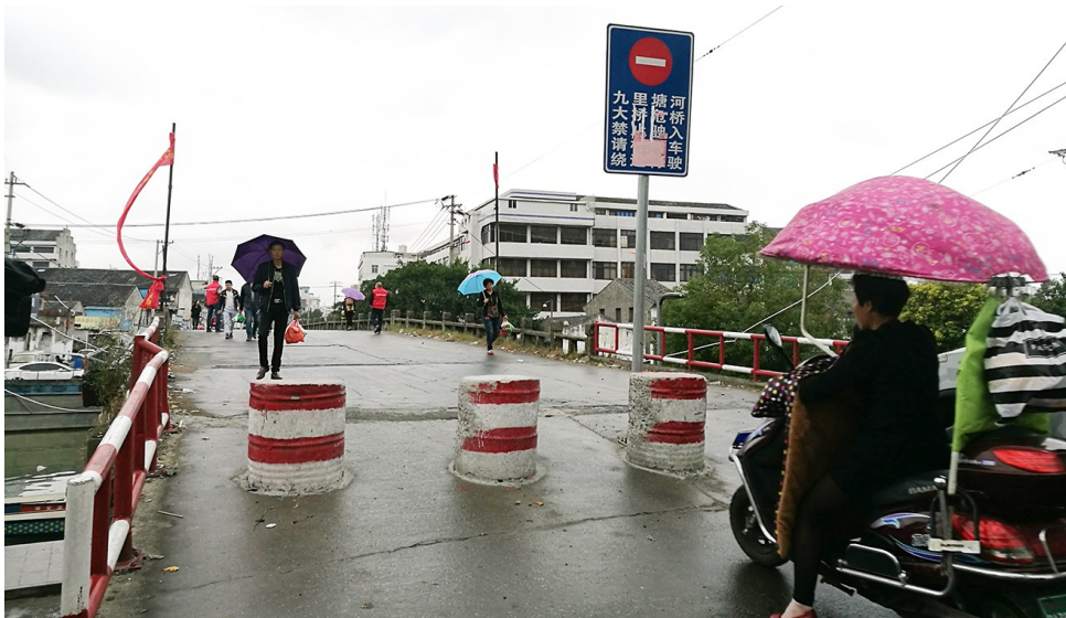
九里大桥已禁止机动车通行
