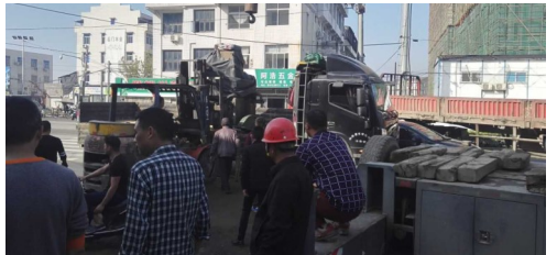
拆除违章建筑
