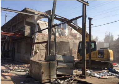
拆除历史违章厂房
