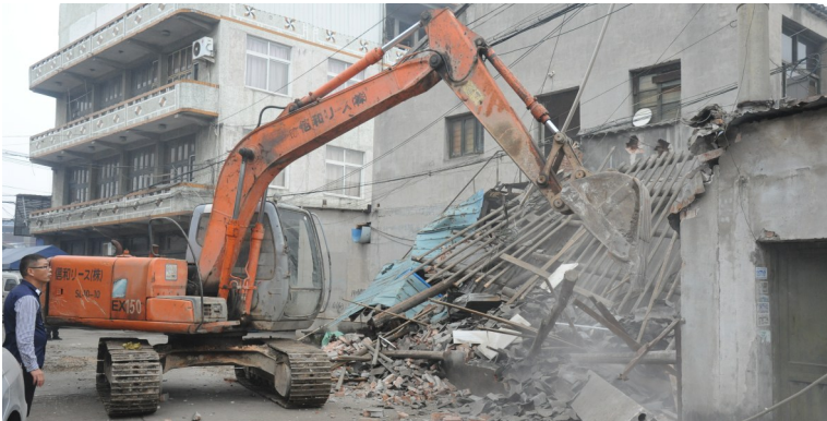
拆除新渎村一号地块瓦房
