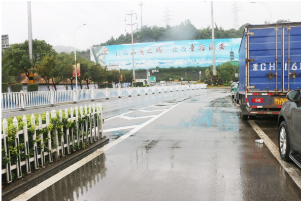
虹桥北路(高速入口处)积水点改造后雨后路况
