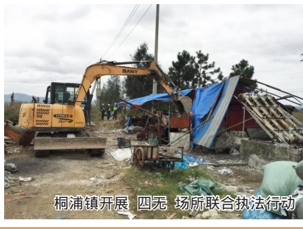
拆除违章建筑
