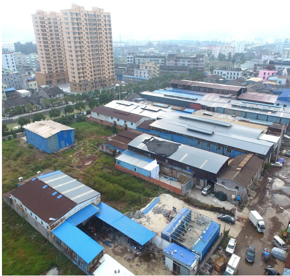
新溪村违章建团块拆除前
