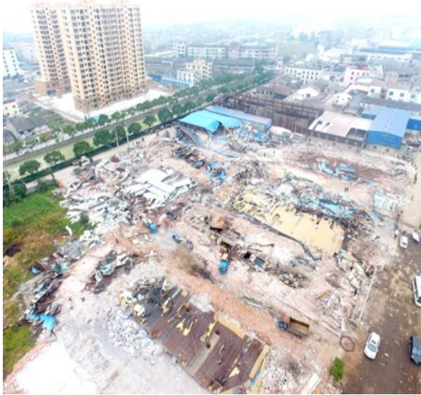
新溪村违章建团块拆除后
