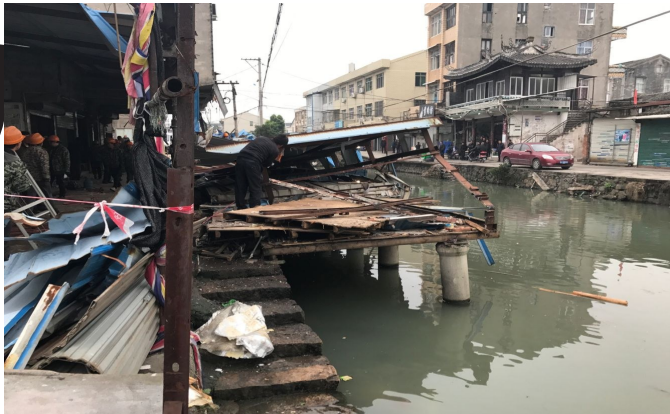
拆除上望沥新桥头段沿河违章棚屋
