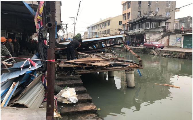
拆除上望沥新桥头段沿河违章棚屋
