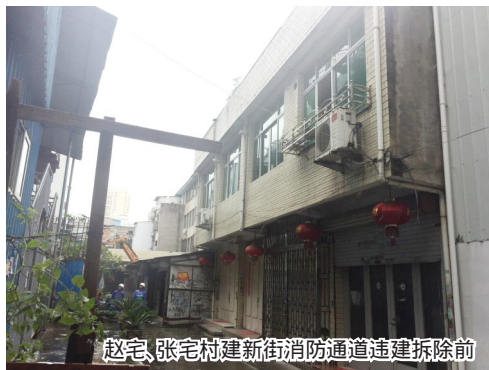
赵宅、张宅村建新街消防通道违建拆除前
