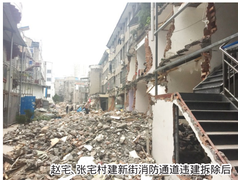
赵宅、张宅村建新街消防通道违建拆除后
