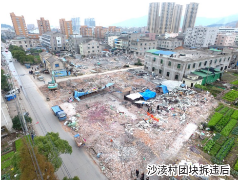
沙溪村团块拆违后
