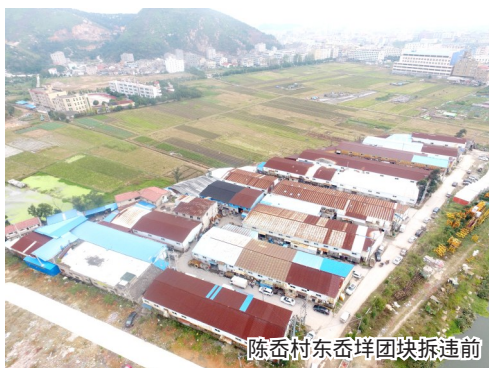
陈岙村东岙垟团块拆违前
