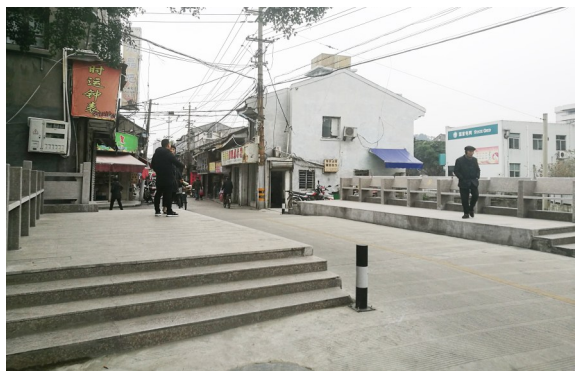
老吊桥改造后通行更安全了
