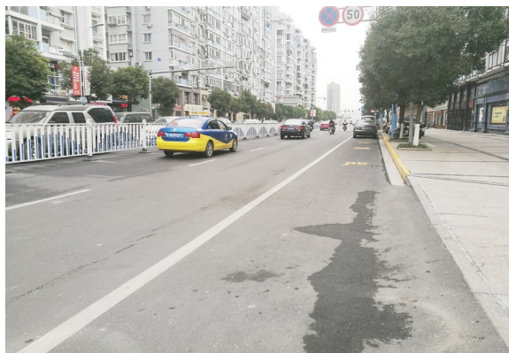
陈虬路与罗阳大道交叉路口改造后,大大缓解了交通压力。
