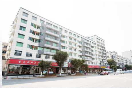
万松东路岭下小区的墙体粉刷一新
