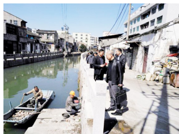
施工队在鲍一鲍二小河上封堵排污口
