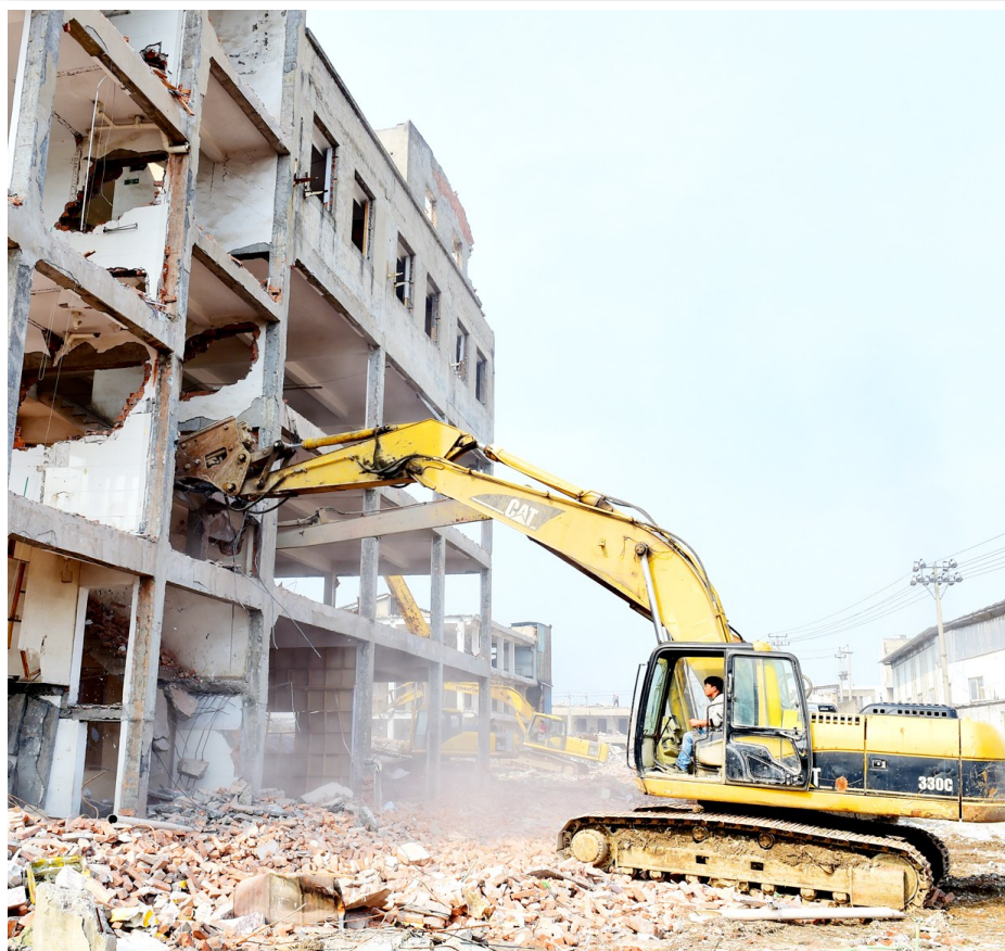
汀田街道拆违现场
