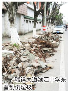
是由于垃圾比较多,护栏倒塌,部分建筑垃圾散落在护栏外。另外,施工人员直接从高处的窗户中往外倒垃圾。督查组人员说:安泰宾馆虽然设置了护栏,但是很不规范,需要整改,同时施工人员不能直接从窗户里往外倒建筑垃圾。
