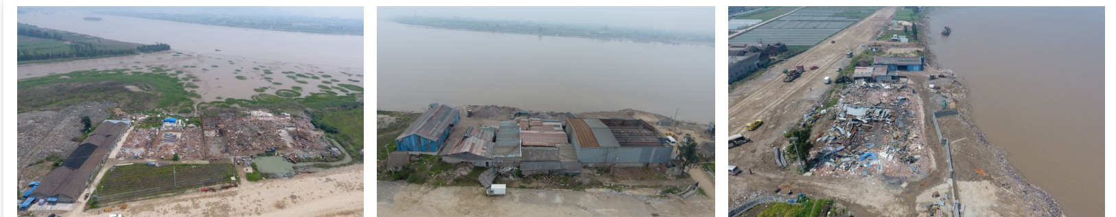
拆除涉水违建
