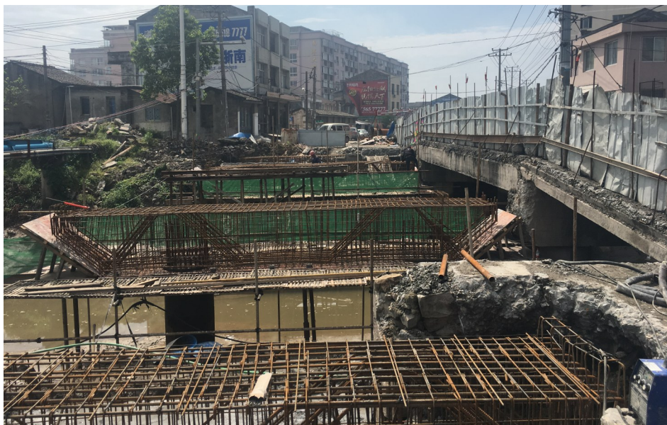
分幅施工，新桥正在施工
