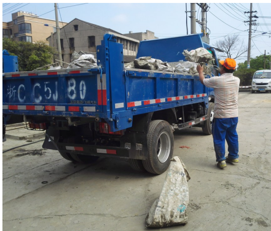
清运“违建”渣土
