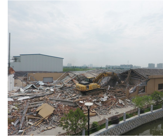
桥里村涉水违建拆除现场
