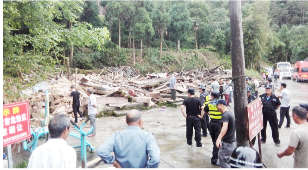
地质灾害避让搬迁项目(拆除后)
