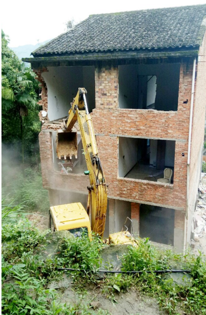
拆除地质灾害隐患点房屋
