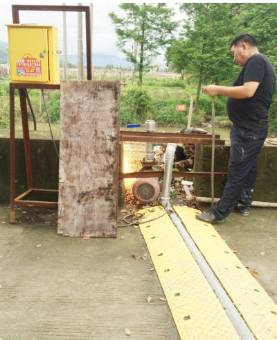
非法取水口被拆除
