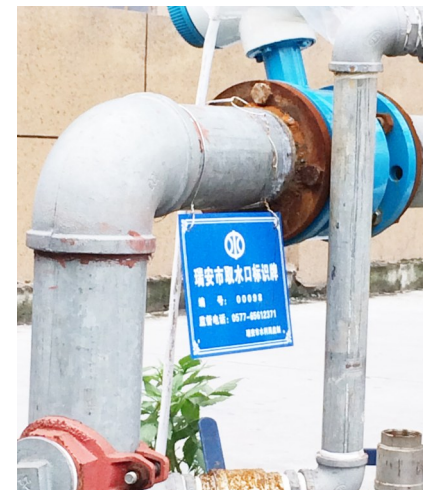
合法取水口挂上了标识牌
